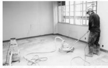
精江市のKコミュニティセンターで丁寧に仕上げる作業風景
